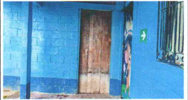
Foto 4: Sustitución de puerta
