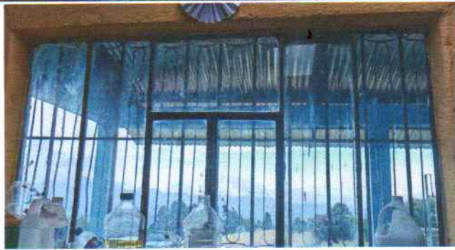
Foto 7: Sustrucción de vidrios
