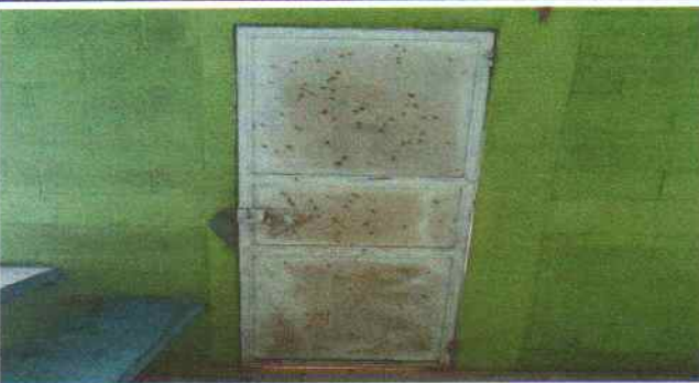
Foto 3: Sustitución de chapa
