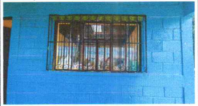
Foto 8: Mantenimiento a balcones de metal
