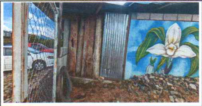
Foto 6: Sustitución de portón de metal
