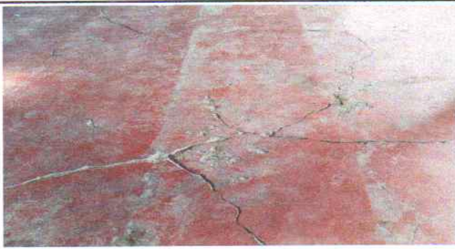
Foto 9: Sustrucción de piso cerámico
