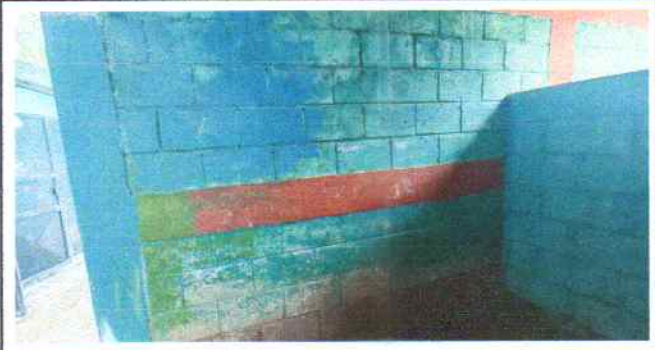
Foto 10: Pintura en muros exteriores e interiores
